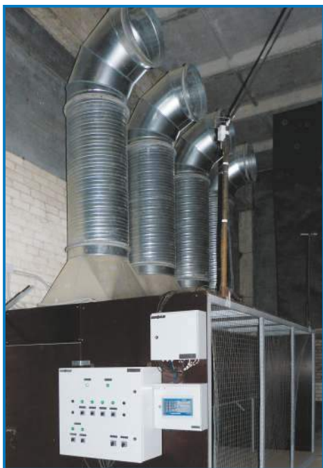
Типичный пример модуля общеобменной вентиляции. Управляющие блоки VENTOGLAS установлены непосредственно на камеру модульного типа (для контейнерного хранения)
