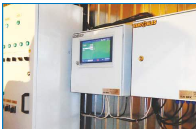
Блоки VENTOGLAS управляющие сушильной стеной прямого действия.
