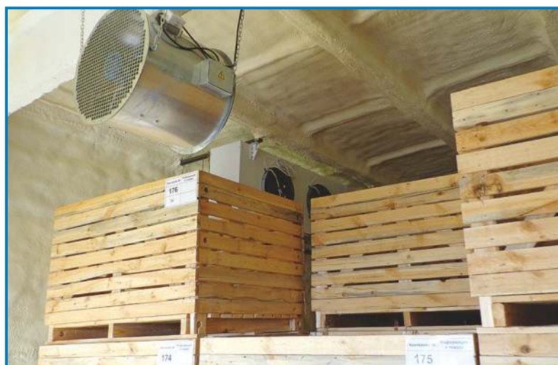
Типичный пример модуля общеобменной вентиляции. Управляющие блоки VENTOGLAS установлены непосредственно на камеру модульного типа (для контейнерного хранения)
