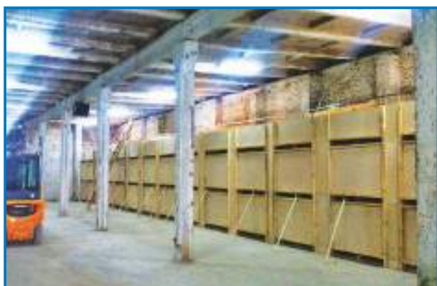
Картофелехранилище со стеной прямого действия.
